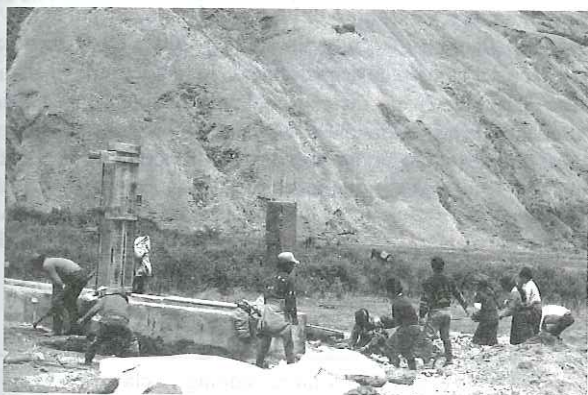
Minga de construcción de un salero fijo en el sector de La Dormida Foto: Archivo IEDECA
